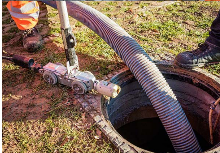
Een robotcamera wordt gebruikt voor een inspectie.
