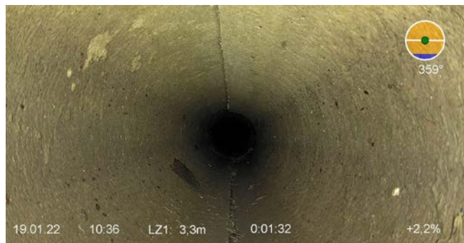
Een schoon Rockflow waterkanaal na reiniging.
